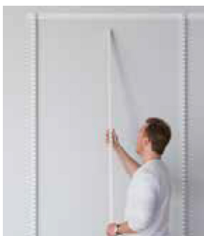
Agățați tijele de suspendare de șina superioară.
